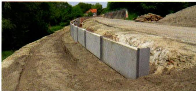
Die Bauarbeiten an der Landstraße nach Strausberg über Torfhaus in Hennickendorf schreiten endlich voran. Eigentlich sollte die Straße Ende 2018 fertig gebaut sein. Die Stützmauer am Wachtelberg ist inzwischen saniert. Jetzt wird eine Absturzsicherung für den Rad- und Gehweg gebaut. Dann muss die Straße noch asphaltiert werden. Geh- und Radweg folgen.
